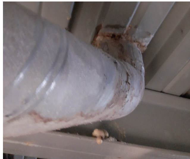
foto /1/ Pohled na 1. prostup dešťového svodu - fotografie z místního šetření provedeného dne 03. 10. 2024
